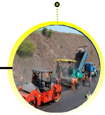
La mezcla asfáltica es tendida y compactada sin cambios en el método constructivo
