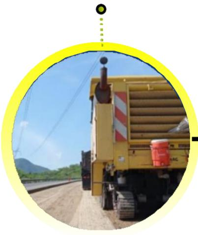
El material existente es fresado y transportado a la planta recicladora
