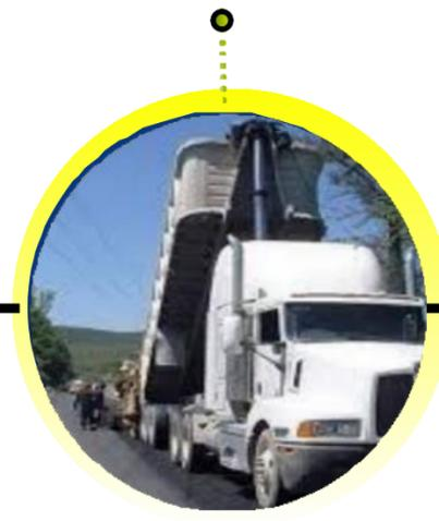
Transporte de mezcla asfáltica reciclada a obra
